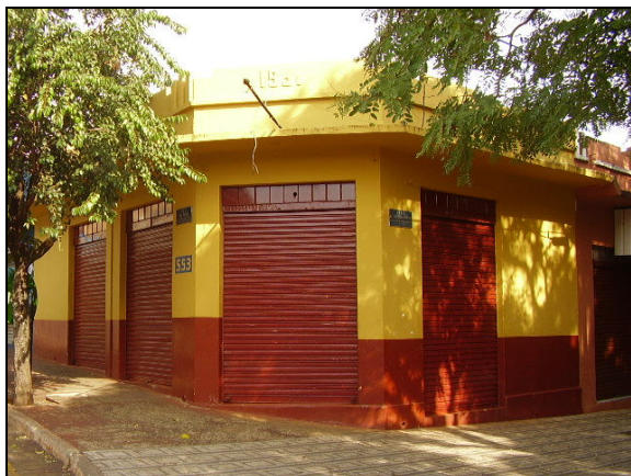
FOTO 02 Edifício comercial da área central.
