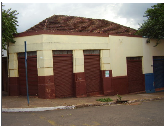
FOTO 03 Edifício comercial da área central.
