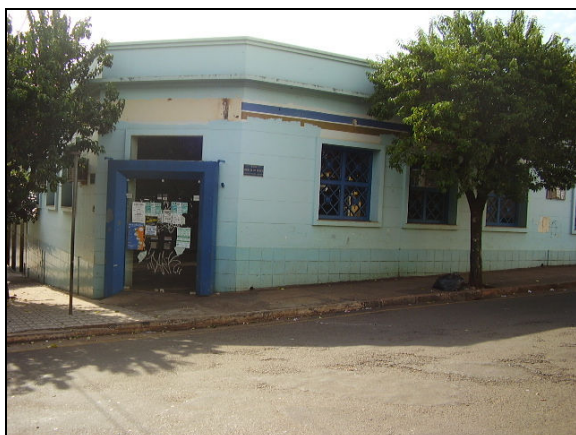
FOTO 04 Edifício comercial da área central.
