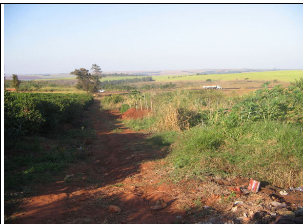
FOTO 15 - Ponto despejo drenagem – Vila Celso Fernandes
