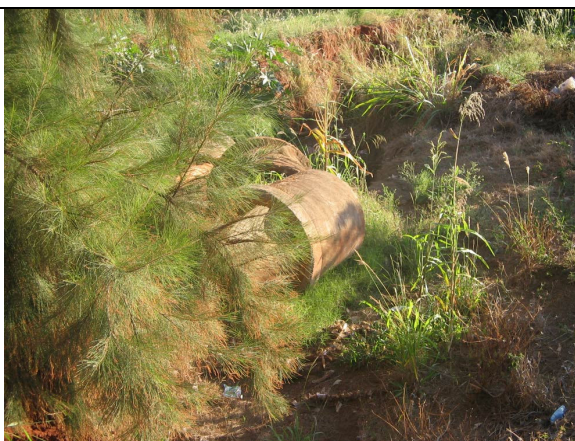
FOTO 19 - Erosão – Vila Yolanda e Jardim D. Sidônia
