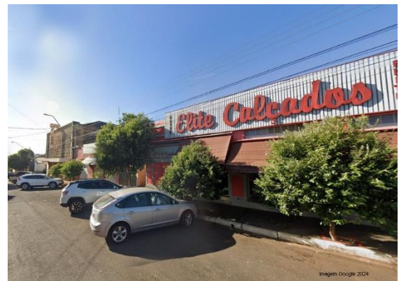
Conflito com toldo e edificação no alinhamento predial
